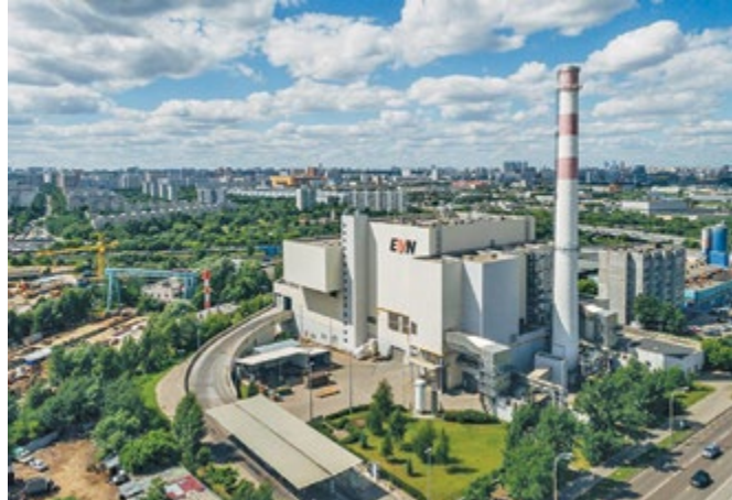
Компания Зульцер Хемтех Рус завершила первый проект в России по наплавке никелевым сплавом на поверхность нагрева котельного агрегата, эксплуатируемого компанией АО «ЕФН МСЗ 3» на мусоросжигательном заводе в Москве.
